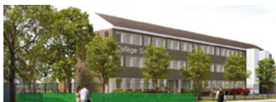
Vue du bâtiment B – externat existant restructuré
