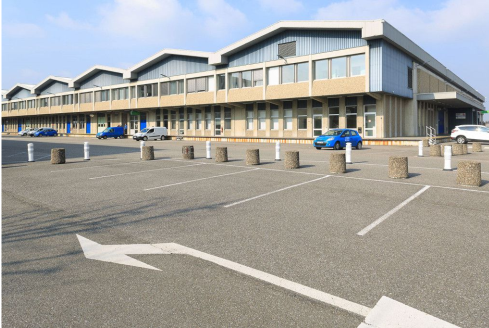
Bâtiments de Strasbourg Électricité Réseaux à Mundolsheim
