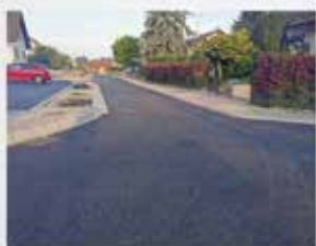
AMENAGEMENT DE VOIRIE
