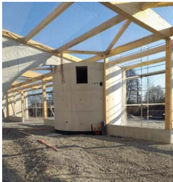
Installation de la cuve 60 m 3 du nouvel atelier municipal
