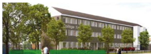
Vue du bâtiment B – externat existant restructuré
