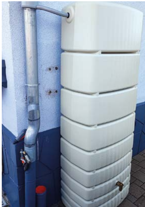
Exemple de déracordement et mise en place de cuve de récupération des eaux pluviales
